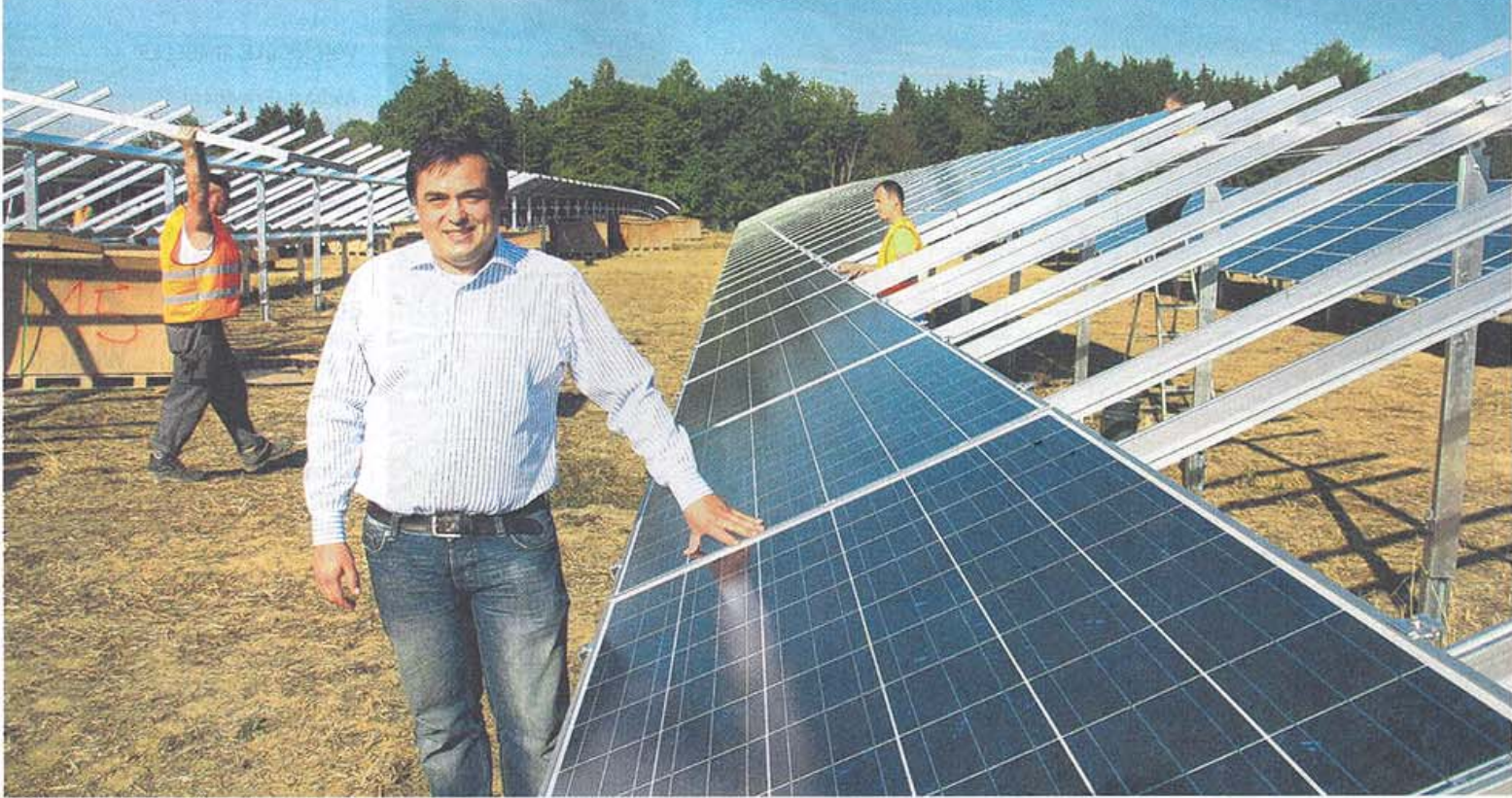
Geschäftsführer Martin Bichler von der Energiebauern GmbH freut sich, dass im neuen Solarpark bei Wiffertshausen die Module installiert werden. Foto: Andreas Schmidt
