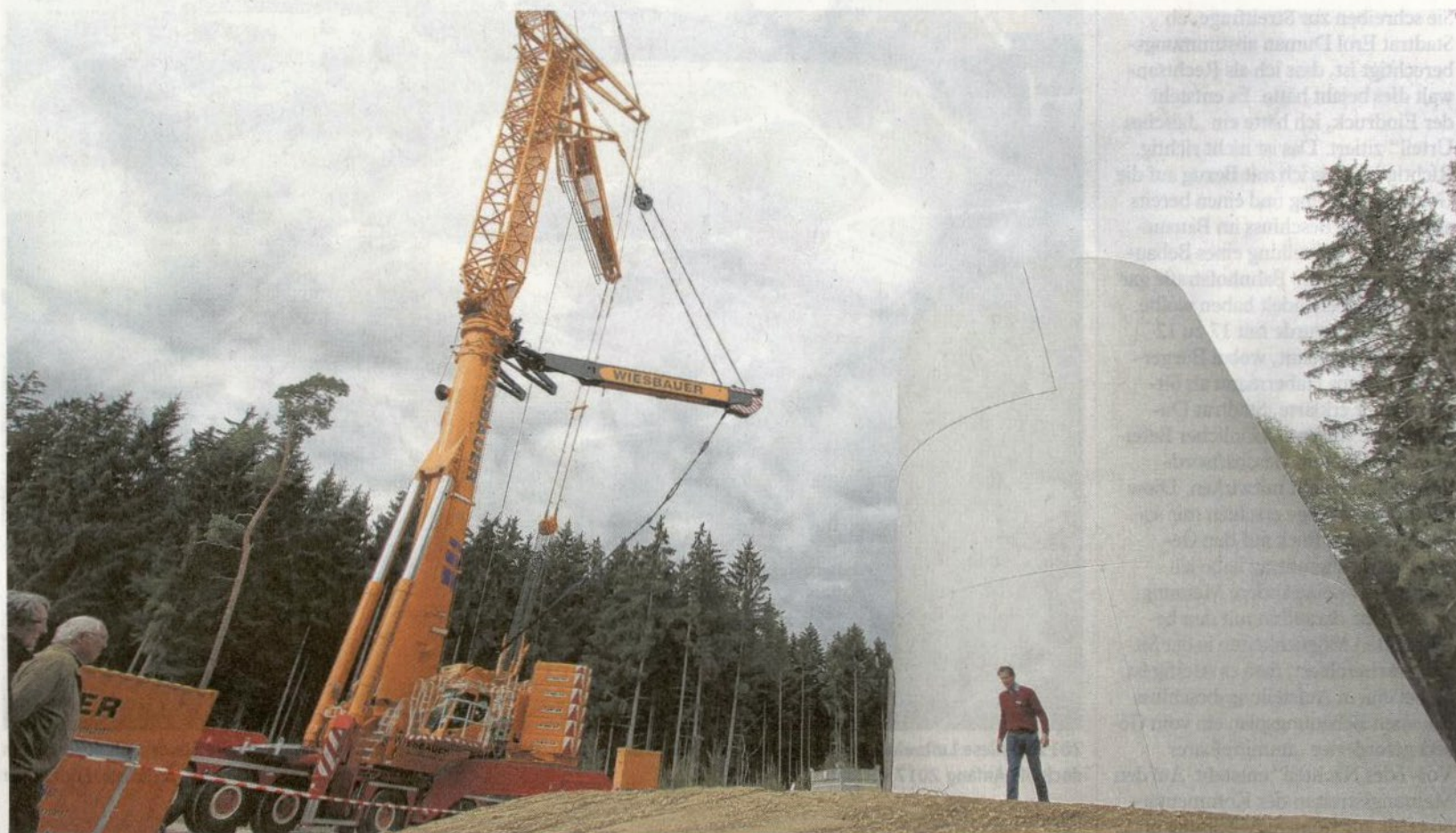
Die Windräder im Blumenthaler Forst wachsen. Bei einer Baustellenbesichtigung zwischen Sielenbach und Laimering kürzlich waren schon Halbschalenelemente aus Beton zu sehen, die den unteren Teil des Turms bilden. Gestern ging es am Verwaltungsgericht Augsburg um die Windräder. Foto: Sophie Schmid
