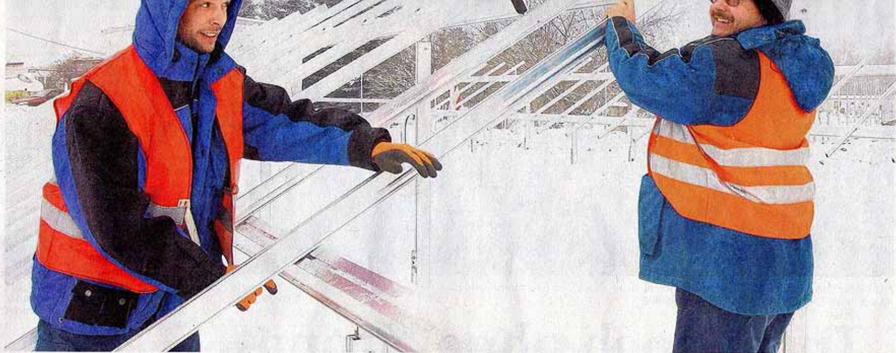
Der Aufbau der vielen Hundert Gestelle für die Module der Solaranlage in Falkenhain ist für Sven Großer und René Allner harte Arbeit.
