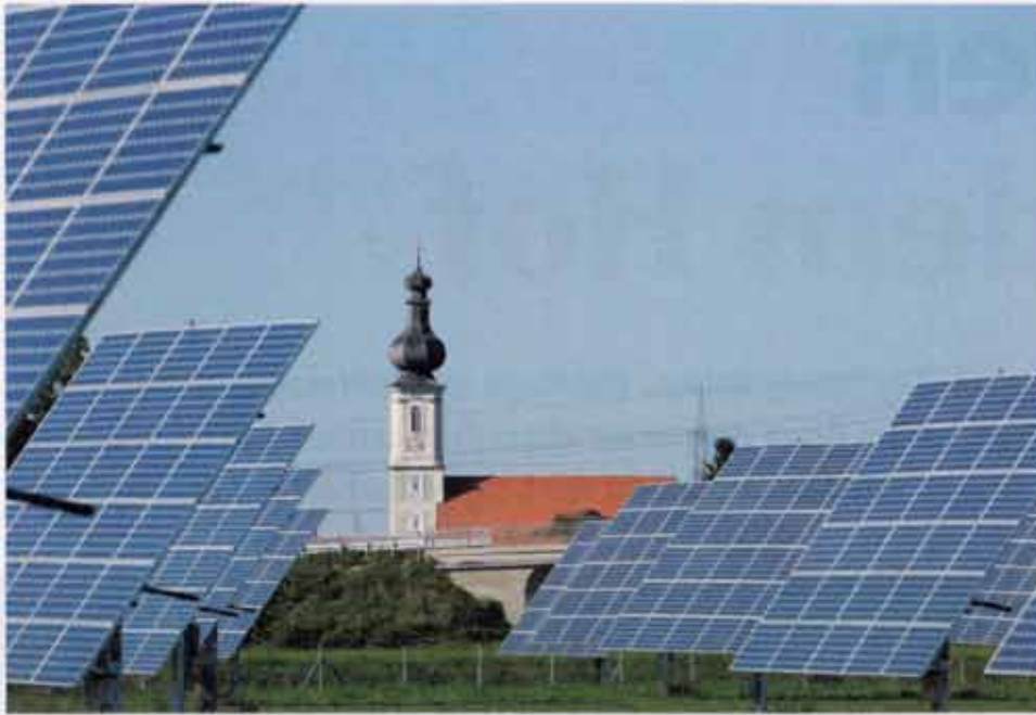
Im Süden scheint viel Sonne; hier boomen Solarparks. Einige Gemeinden wehren sich erfolgreich gegen Anlagen auf dem Acker.
