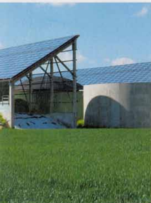
Die Biogasanlage von Hubert Miller. Statt auf dem Acker befinden sich nun die PV-Module auf den Dächern der Fahrhilos.
